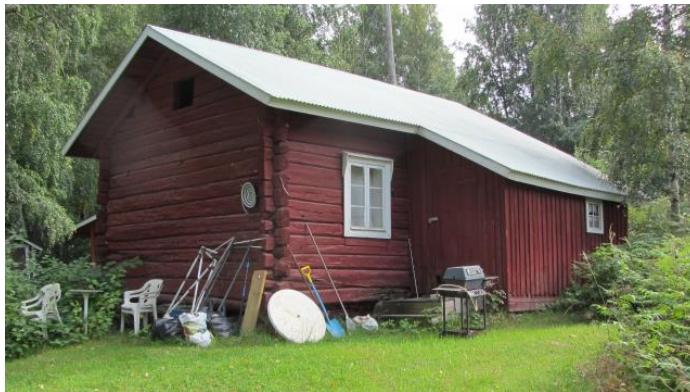
Kuva 4: Siltalan saunarakennus (kärryliiterin vieressä)
