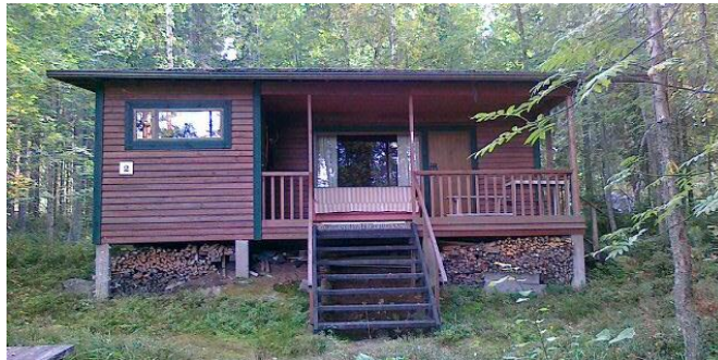
Kuva 9: Tilusojan 1975 rakennettu kesäasunto, 56 m 2 (kuva: Kaisa Jokinen).
