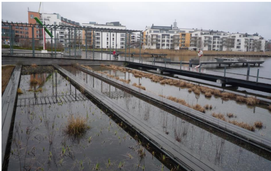
Kuva 9: Huleveden viivytysallas Tukholmassa 2014
