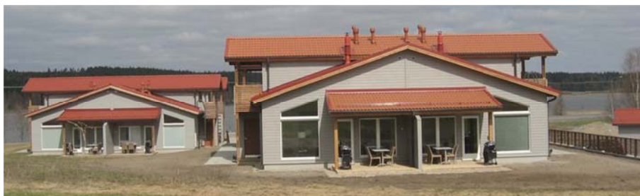
Kuva 6: Uusia lomarakennuksia välittömästi suunnittelualueen koillispuolella.
