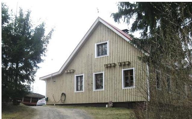
Kuva 10: Uskolan päärakennus. Rakennuksella on vanha hirsirunko. Lisävuoraus ja lisärakentaminen ovat muuttaneet rakennuksen ilmettä alkuperäisestä.
