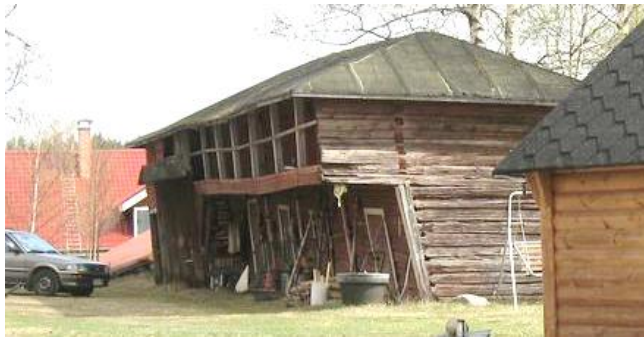
Kuva 11: Päärakennusta vastapäätä sijainnut luhtiaitta on purettu 2015.
