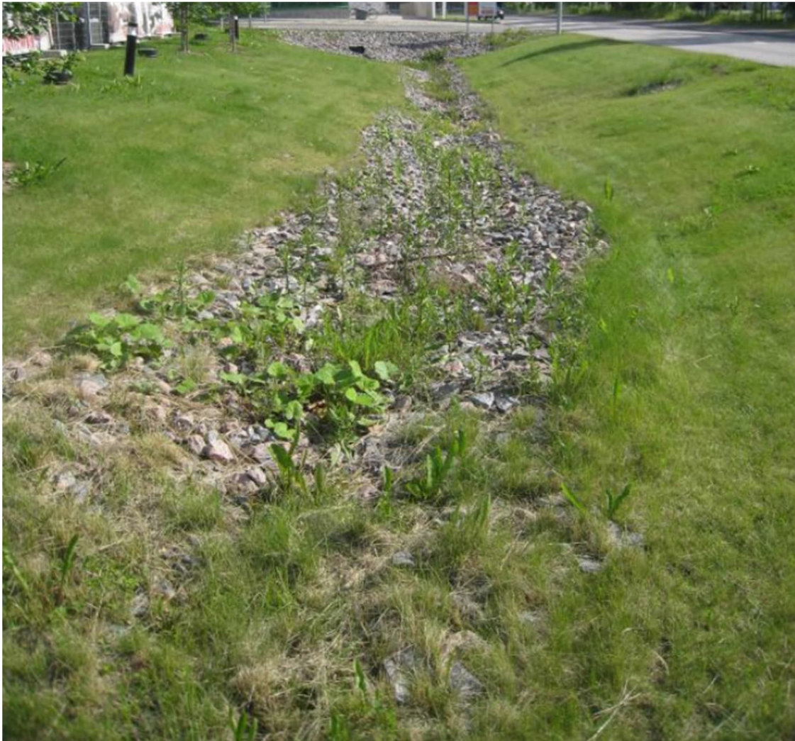
Kuva 7. Esimerkki hulevesien kasvipeitteisestä viivytyspainanteesta. [10]
