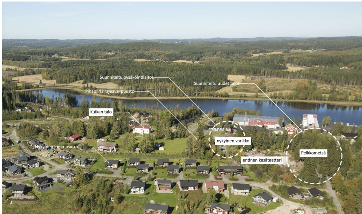
Kuva 9 Kuikan talo ja sen sijoittuminen suhteessa yleiskaavaluonnos A-vaihtoehtoon. Uutta rakentamista on suunniteltu Kuikan talon pohjoispuolelle Peikkometsän alueelle.
